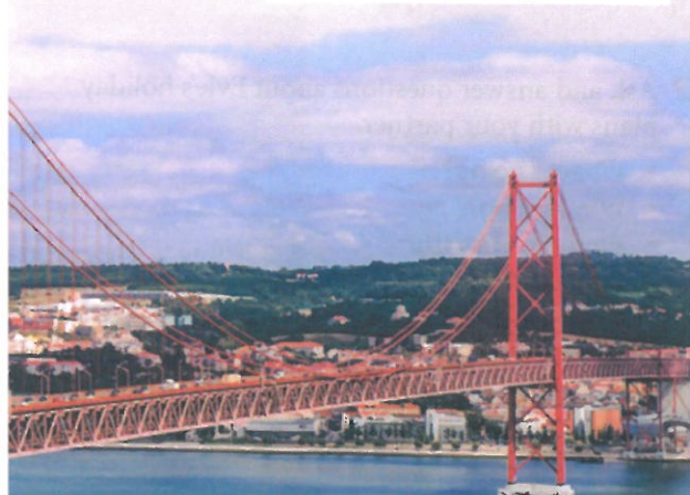
The 25 de Abril Bridge, Lisbon
